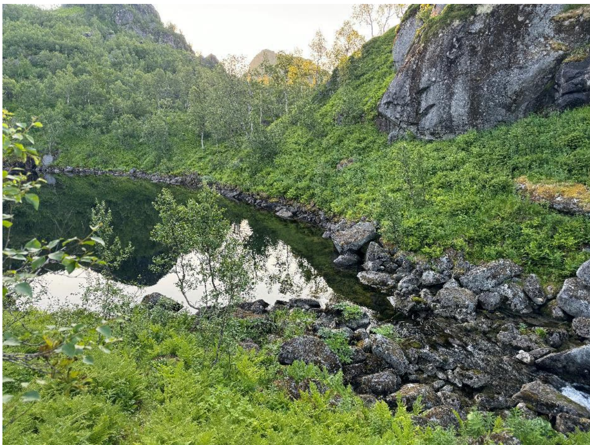
Figur 2.3. Inntaksområde ved utløpet av Vasskrunvatnet.
